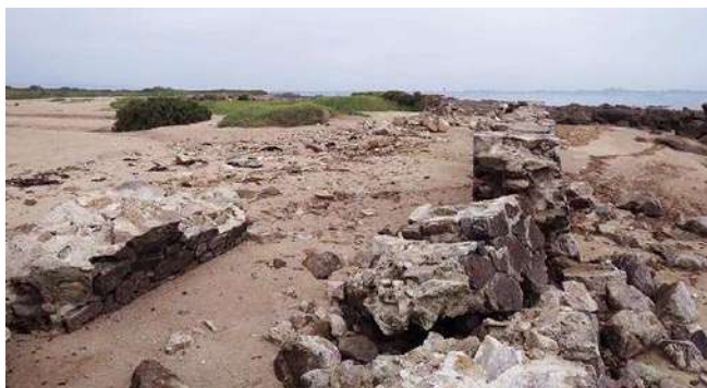
Tatihou : état du mur de garantie Est.
